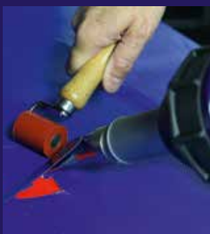
Réparation par soudage de pièces
