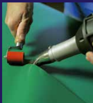
Soldadura solapada
