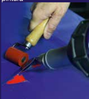
Soldadura de parche
