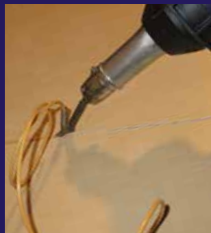
Revestimiento de suelos
