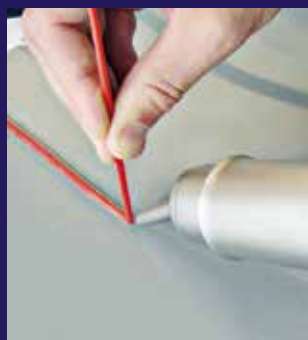
Soldadura por empuje
