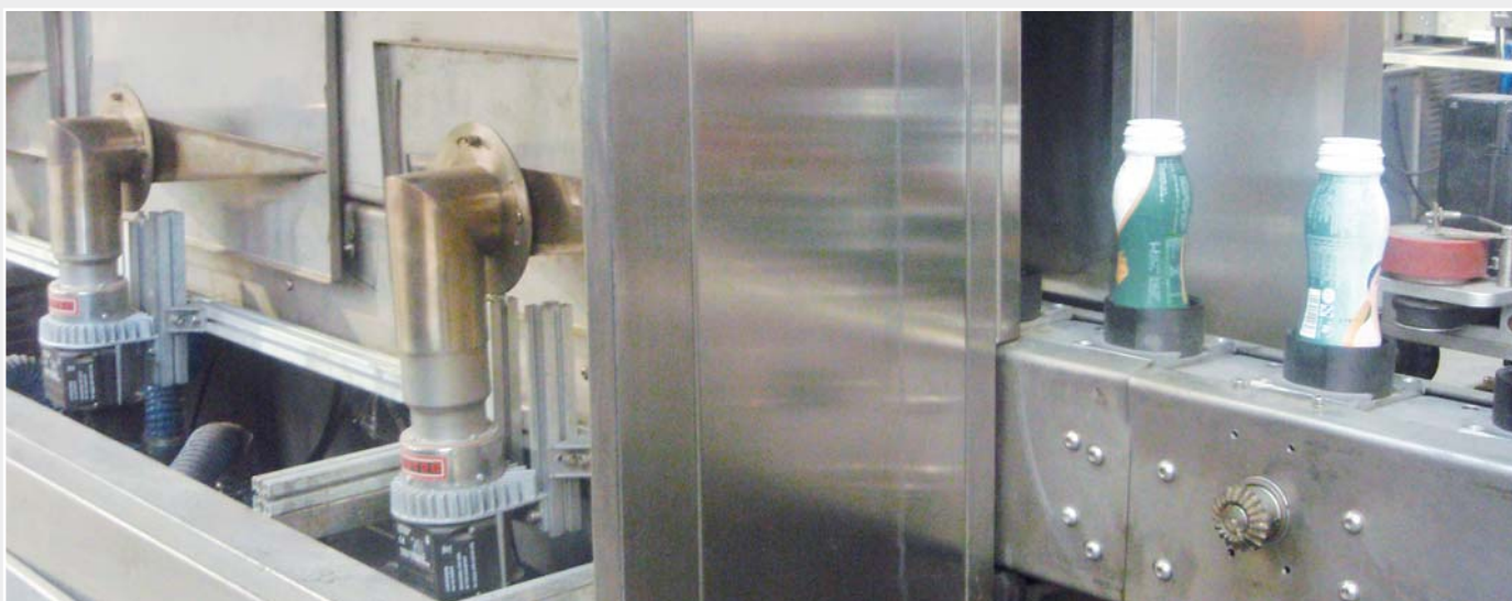
Schrumpftunnel mit beidseitig drei Lufterhitzern LE 5000.
