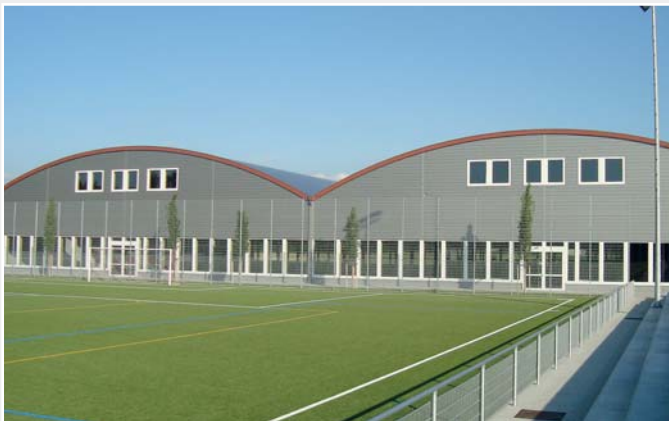
La nave cuenta con cinco pistas dobles de tenis.
