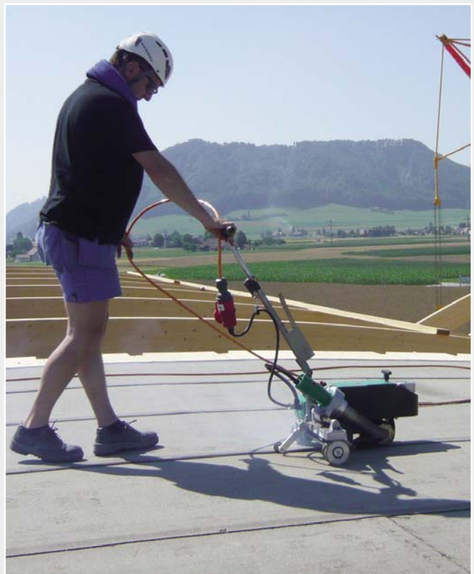
Einfache Geräteführung und sauberes Arbeiten mit dem BITUMAT B2.
