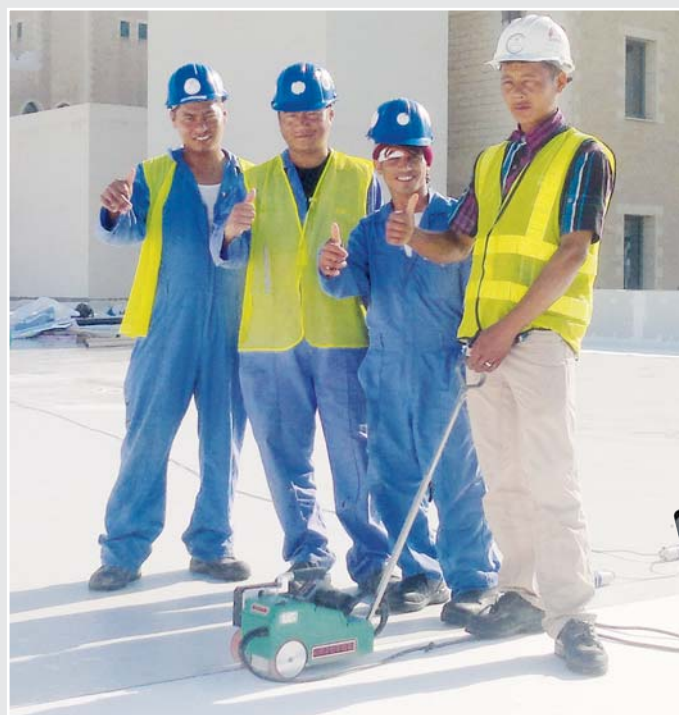
L'équipe de pose satisfaite de l'entreprise Al Shirawi Contracting Co.
