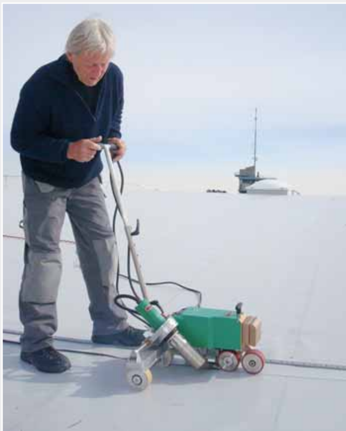
Varimat V durante la soldadura a solapa de las láminas de PVC.
