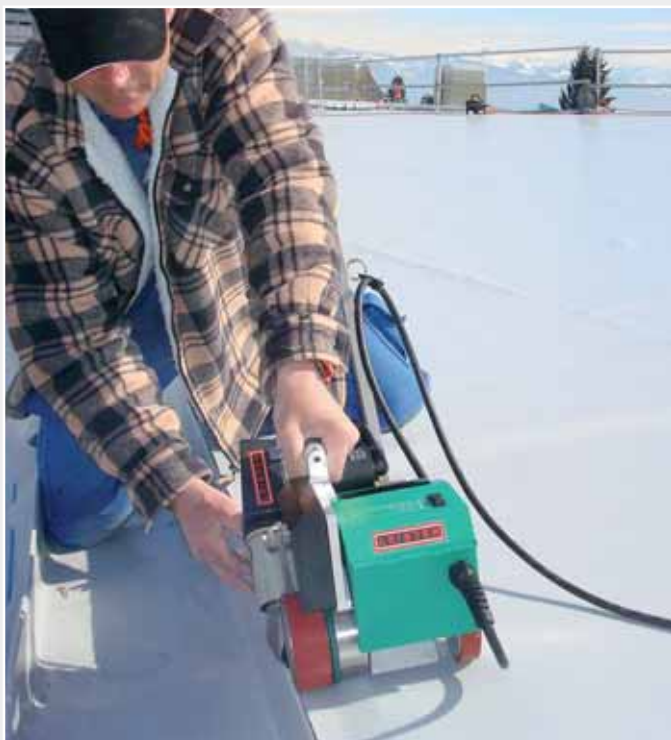
La UNIROOF E durante la soldadura del canalón.
