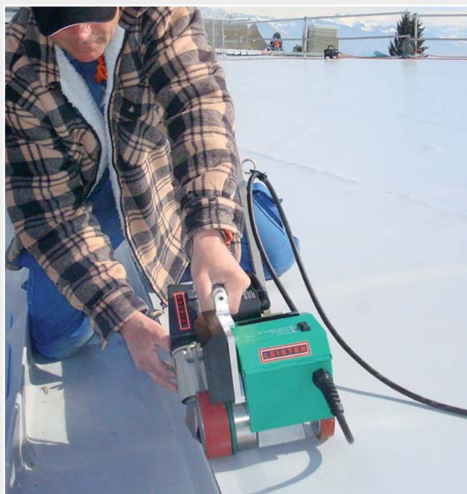
Der UNIROOF E beim Verschweissen an einer Regenrinne.
