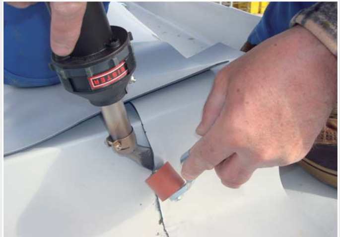
...und der kleinere HOT JET S bei der Verarbeitung von anspruchsvollen Details.
