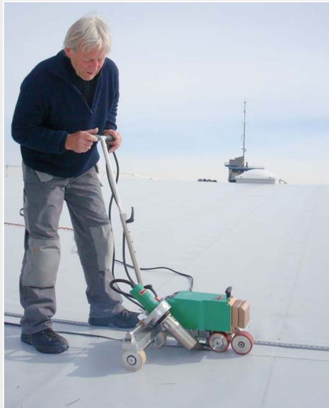
Der VARIMAT V beim Überlappschweissen der PVC-Bahnen.
