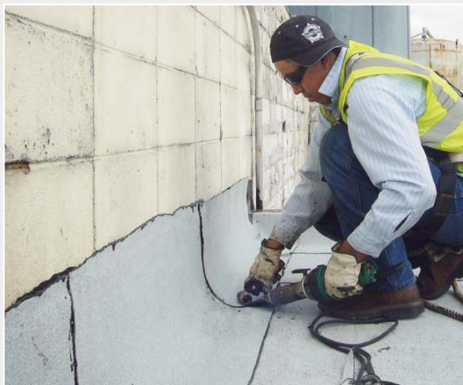
Le modèle performant ELECTRON avec buse à fente large pour le soudage de détail.
