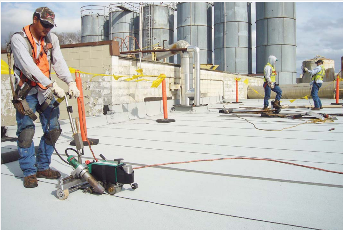
Soudage sûr et propre des lés en bitume avec le BITUMAT B2.
