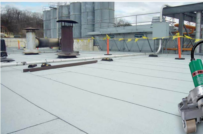
Le BITUMAT B2 soude des cordons propres et homogènes.
