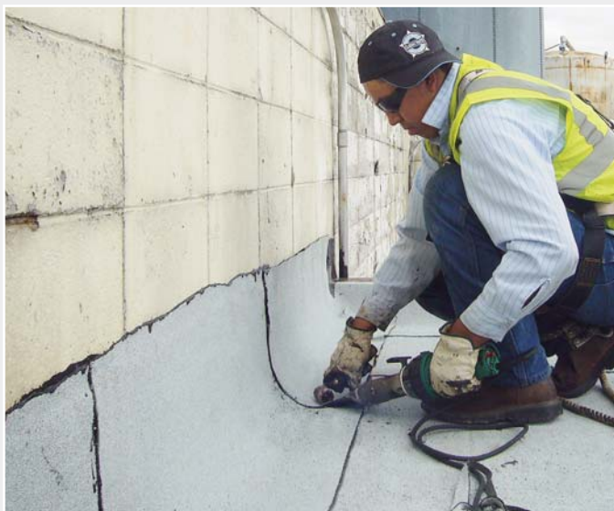
Der leistungsstarke ELECTRON mit Breitschlitzdüse für das Schweißen von Details.
