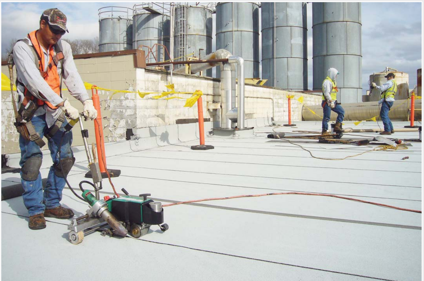
Sicheres und sauberes Schweißen der Bitumenbahnen mit dem BITUMAT B2.
