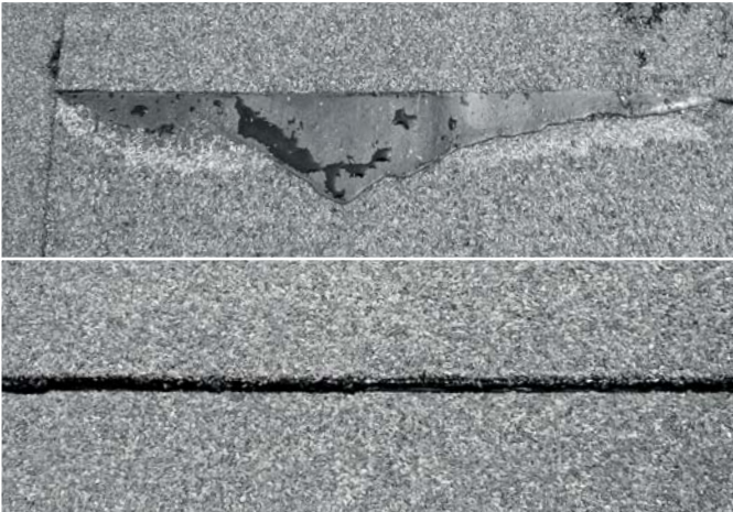
Detailvergleich zweier Schweißnähte mit offener Flamme (oben) und BITUMAT B2 (unten).
