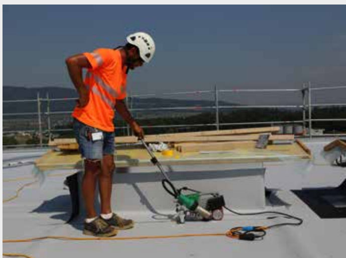
Saldatura vicino ai bordi possibile fino a 100 mm
