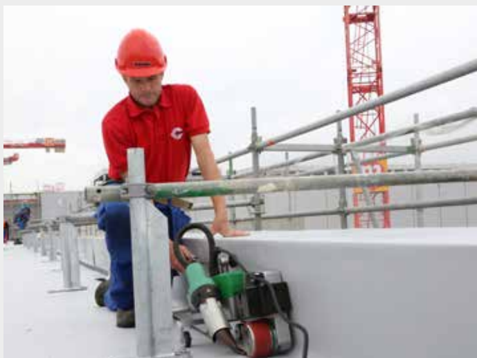
Soudage derrière les poteaux d'échafaudage
