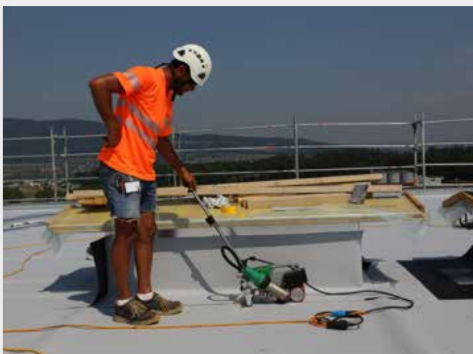
Soudage tout près du bord, possible jusqu'à 100 mm
