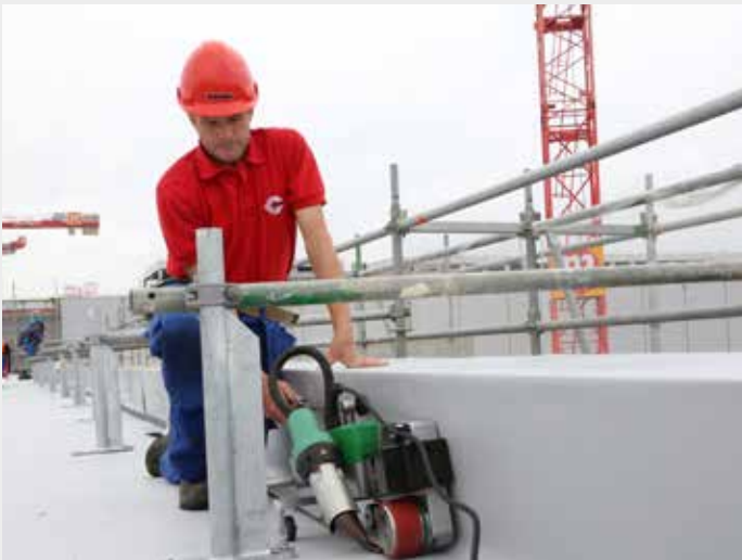
Schweissen hinter Gerüststangen
