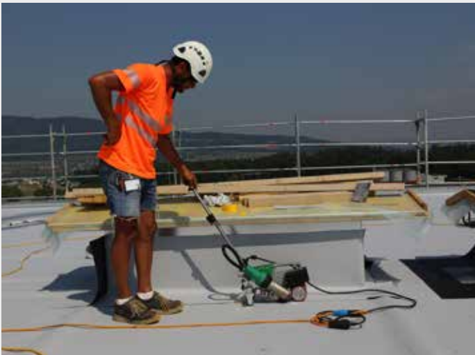
Randnahes Schweißen bis 100mm möglich
