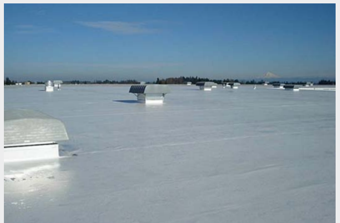
Die Verlegerfirma «Columbia River Roofing» konnte dank der Zuverlässigkeit und Effizienz der Geräte von Leister die Arbeiten in weniger als zwei Monaten abschliessen.
