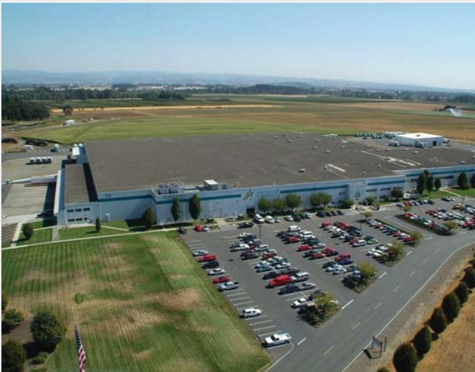
Das massive, 38.000 m 2 große Dach über der Vertriebszentrale von «Food Services of America» in Woodburn.
