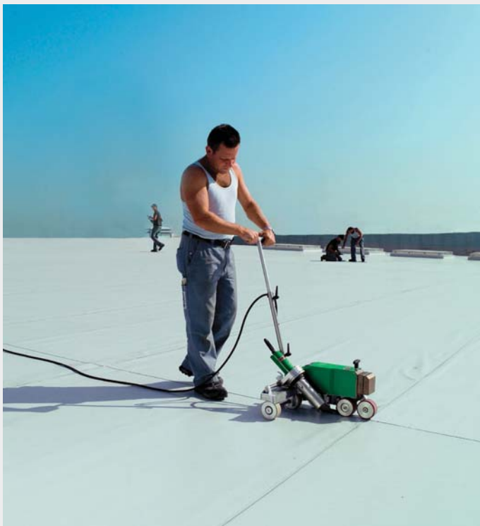
Mit dem VARIMAT V konnte die Verlegerfirma «Columbia River Roofing» 2.000 bis 2.300 m 2 /Tag Dachfläche abdichten.
