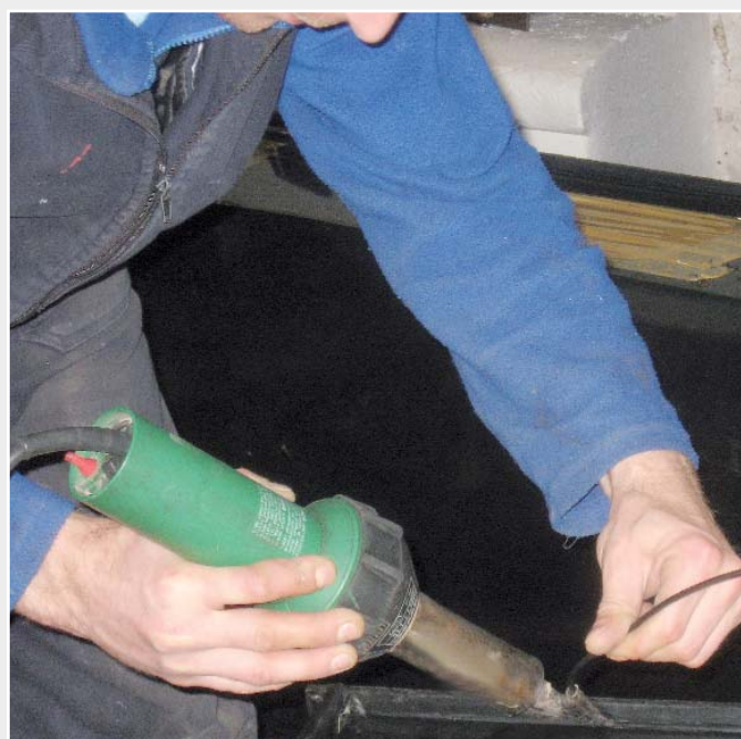
Soudage à air chaud avec le modèle TRIAC S
