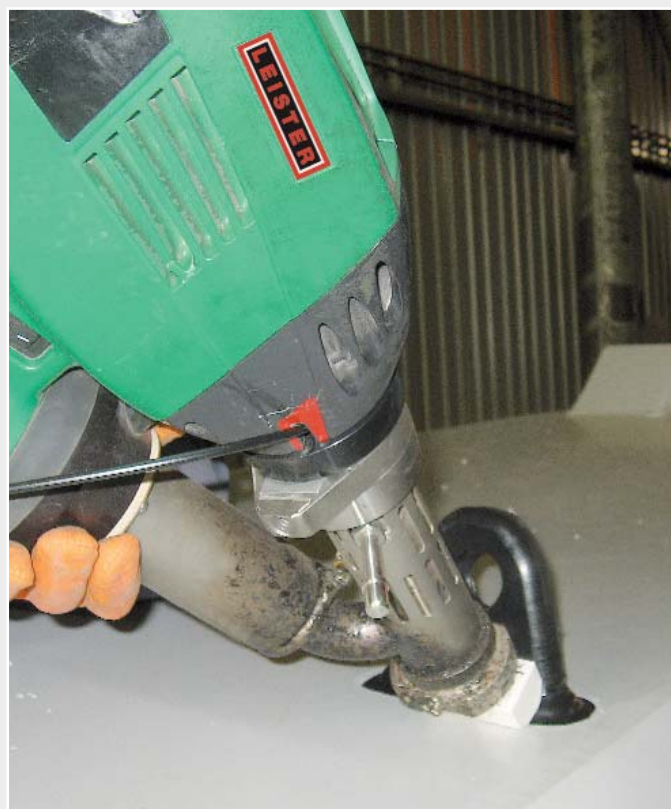
Extrudeuse manuelle pour réaliser un détail
