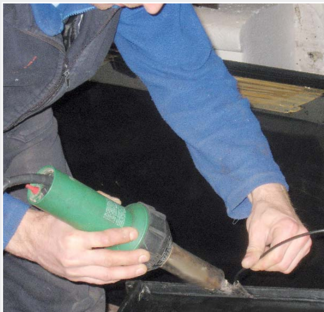
Soldadura por empuje con la TRIAC S
