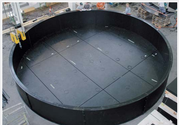
En la imagen anterior se puede observar que están revisando el ajuste de los elementos de la base y la matriz inferior de los elementos de las paredes durante su fabricación.
