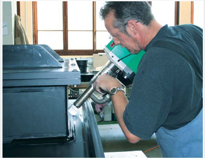
En la imagen anterior se puede observar que se está uniendo por extrusión la ventanilla de inspección en el elemento que conforma una parte curva de la pared PE utilizando la WELDPLAST S.4.
