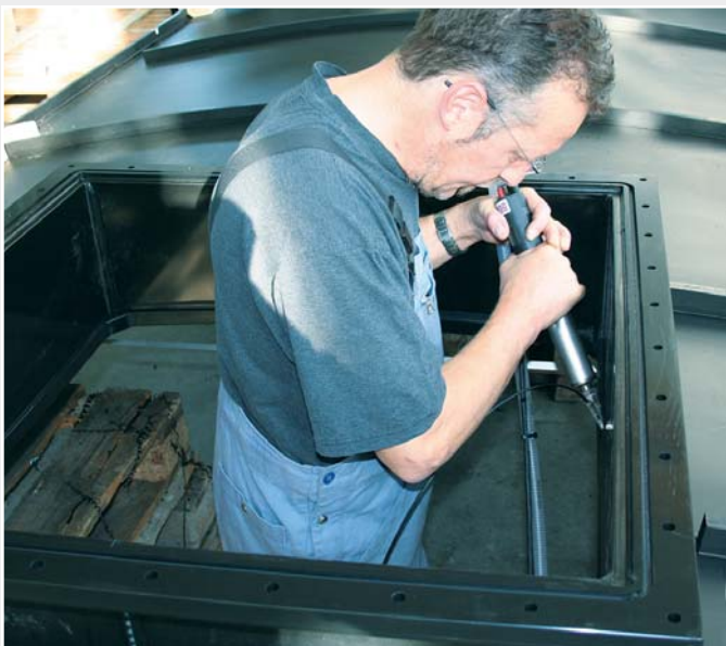
Die Revisionsöffnung wird mit einer DIODE S von Leister fixiert.
