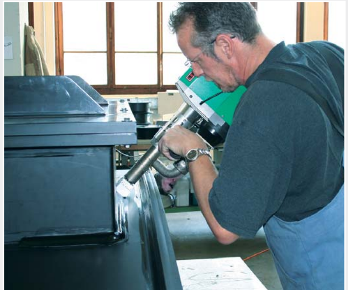
Anextrudieren der Revisionsöffnung auf das gebogene PE-Wandelement mit einem WELDPLAST S.4 .
