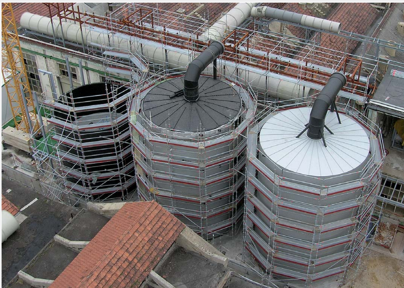
Die fast fertigen Silos kurz vor dem Anschluss an das Zellulosewerk.
