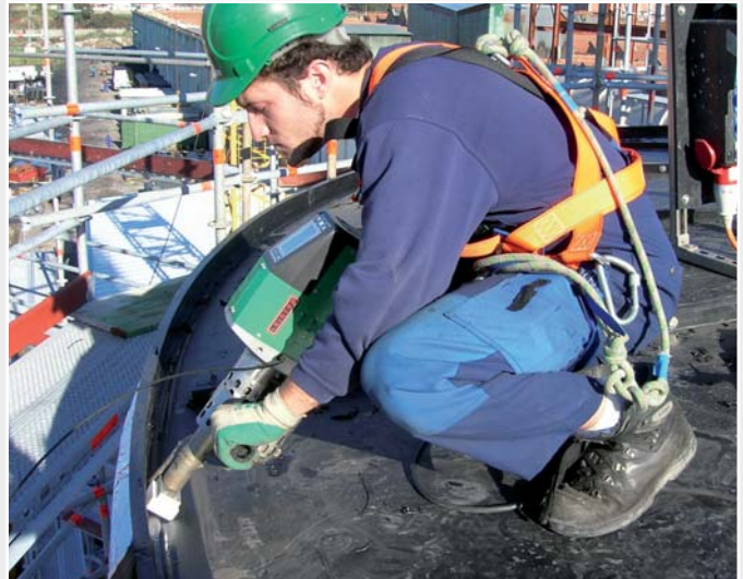
Verbinden der Wand- mit den Dachelementen in Spanien mit einem WELDPLAST EC 4.
