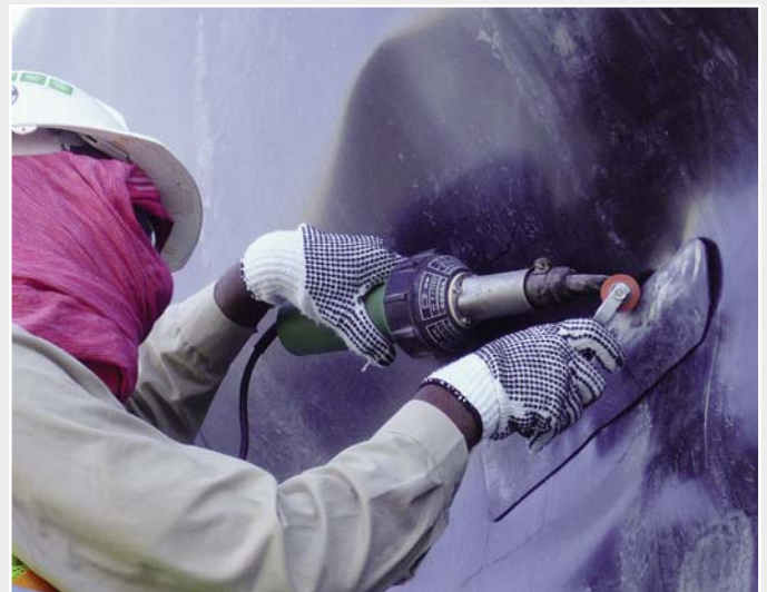
Der TRIAC wird in Dubai auch für das Heften von Kunststoffabdeckungen eingesetzt.
