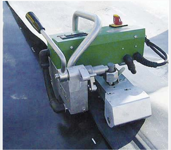
Der ASTRO verschweisst die HD-PE-Dichtungsbahnen mit einer Geschwindigkeit von bis zu 5 m/Min.
