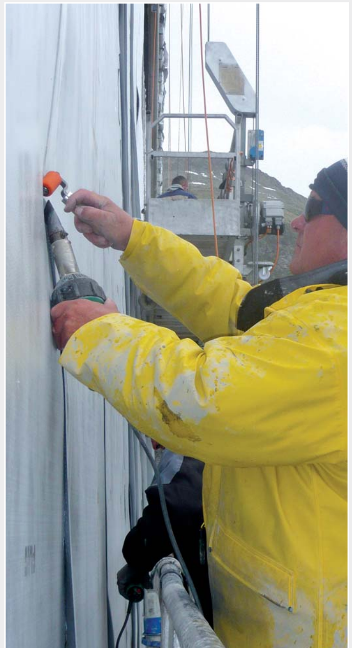
Sämtliche Kunststoffdichtungsbahnen wurden mit dem zuverlässigen Handschweissgerät TRIAC S verarbeitet.
