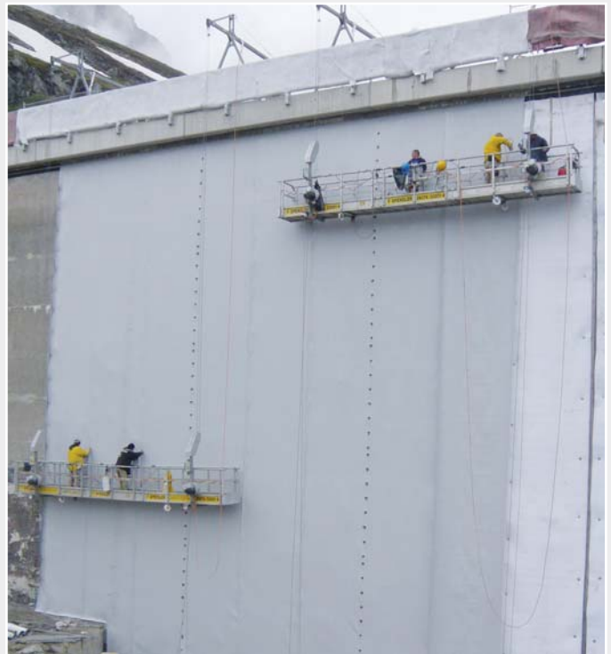
Arbeiten an der Seitenmauer. Die einzelnen Bahnen werden jeweils parallel verschweisst.
