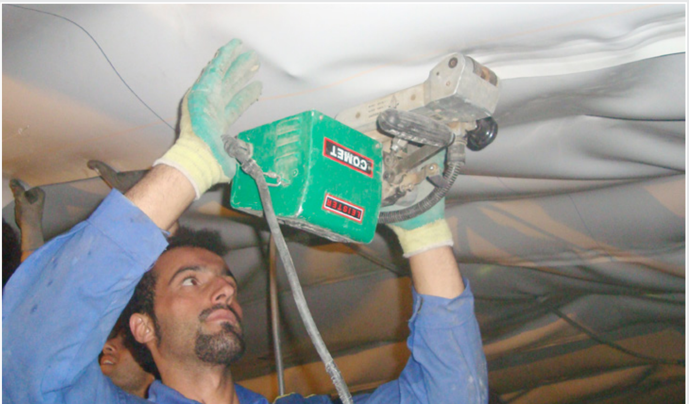
Überkopfschweissen mit dem Heizkeil-Schweissautomaten TWINNY T.
