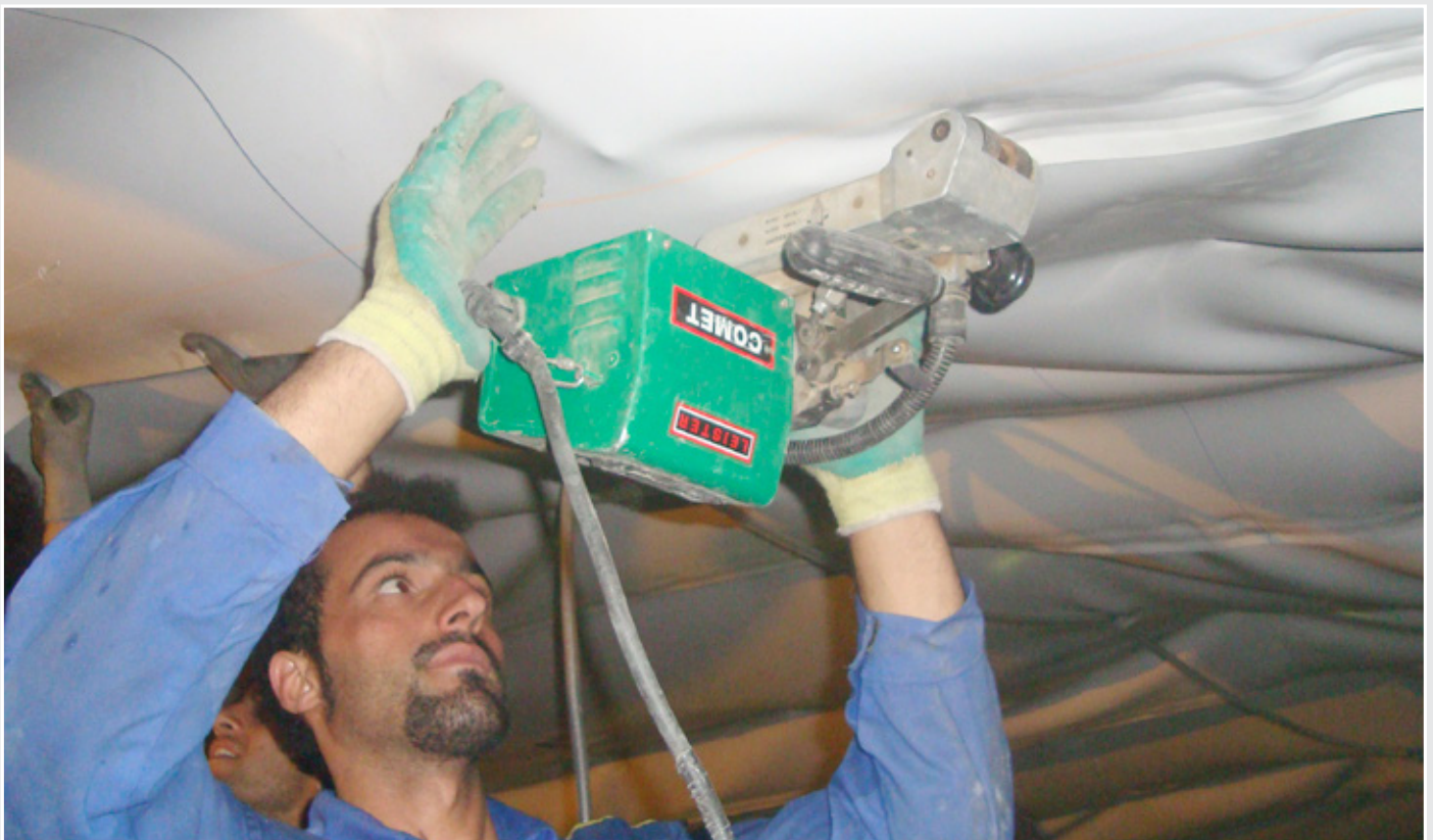
Soldadura de techo con el dispositivo automático de cuña térmica COMET.
