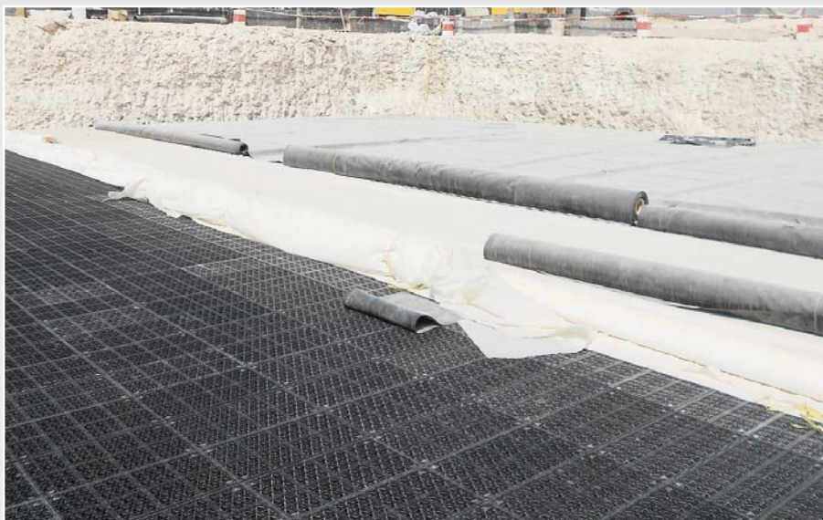
Im Vordergrund die gestapelten Körbe, hinten der zweischichtige Systemaufbau mit Geotextil und HDPE-Dichtungsbahn.
