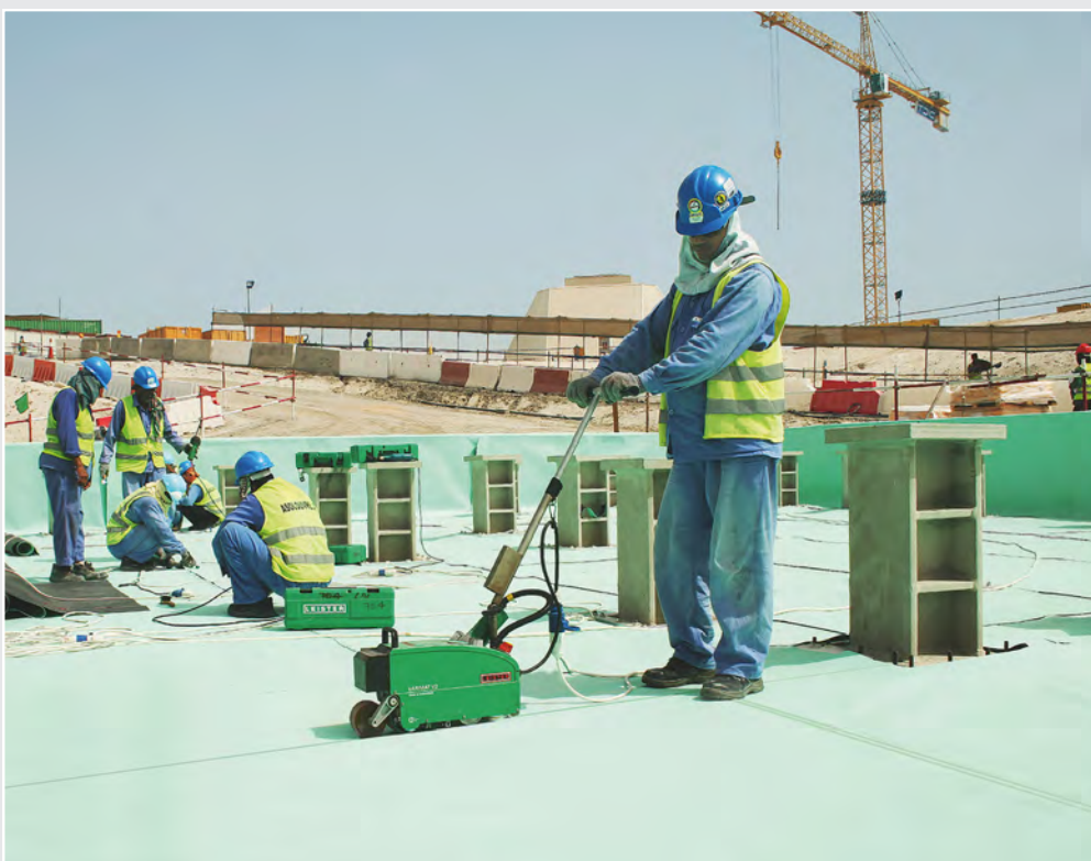
Für Basisnähte wird der leistungsfähige Heissluft-Schweissautomat VARIMAT V2 genutzt.
