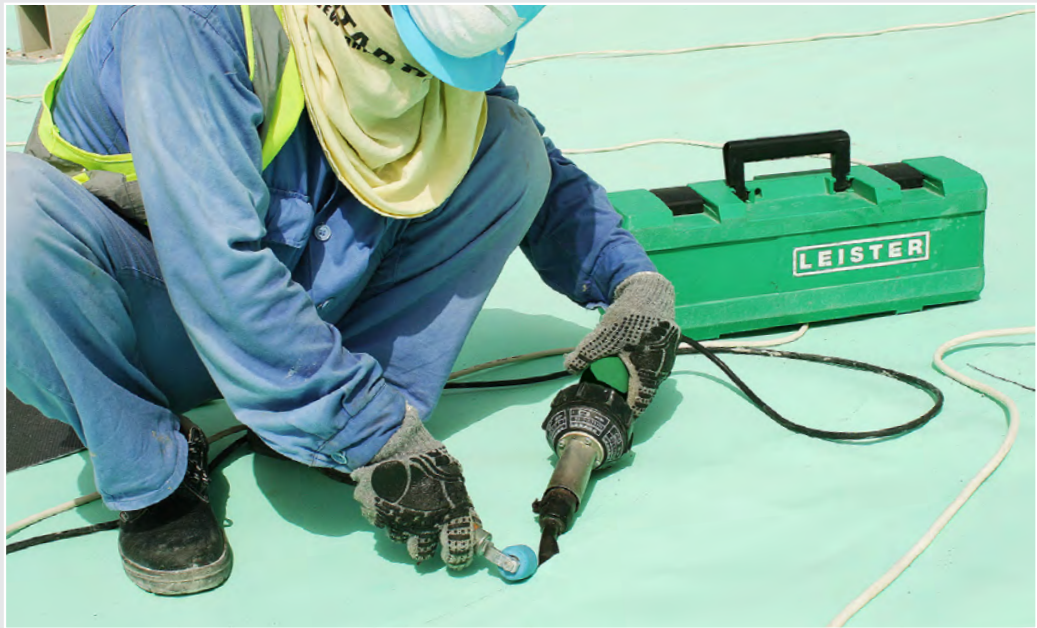
Alle Details werden mit TRIAC AT Heissluft-Handgeräten geschweisst.
