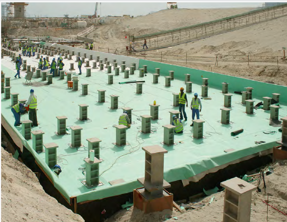
Ein Teil des Fundamentes mit dem dreiteiligen Sicherheitssystem.
