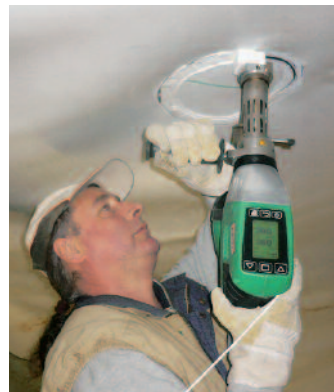
Bild 11: Überkopf-Extrusionsschweißen im Tunnel (Dichtungsbahn B – PE-LLD, Schweißzusatz B – PE-LLD) mit dem Handextruder vom Typ „Leister Weldplast S2“
