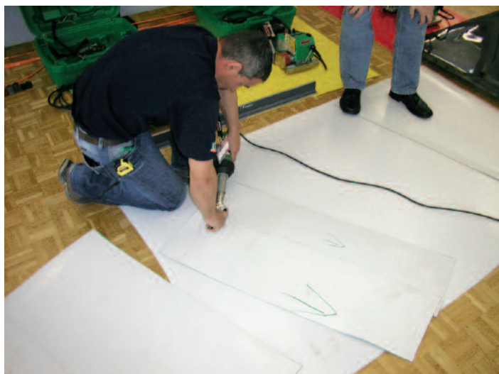
Bild 2: Vorbereitung der Schweißarbeiten, Heften der beiden zu schweißenden Bahnenabschnitte mit einem Wärmegasschweißgerät
