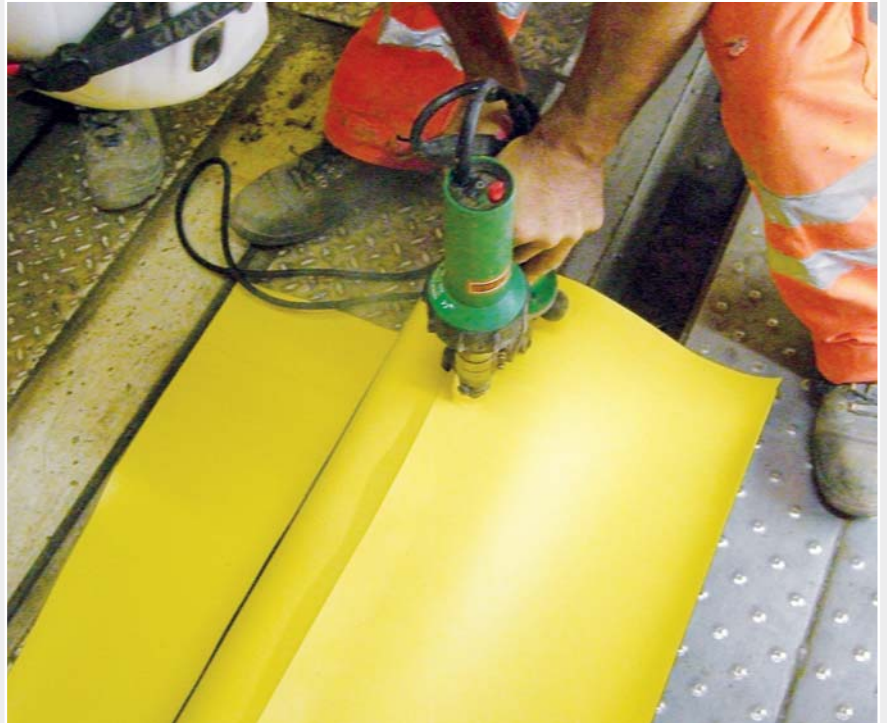
Rouleau de pression « double » et buse de soudage de la TWINNY S.
