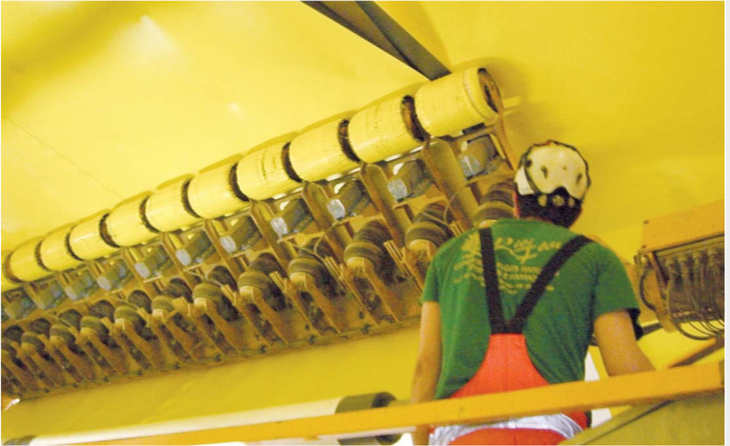
Application mécanique des revêtements d'étanchéité en plastique préfabriqués de 4,30 m de large sur les rondelles de support sous-jacentes. Puis soudage.
