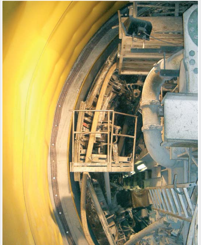
La couche d'étanchéité soudée finie avant le bétonnage de la coque intérieure du tunnel.
