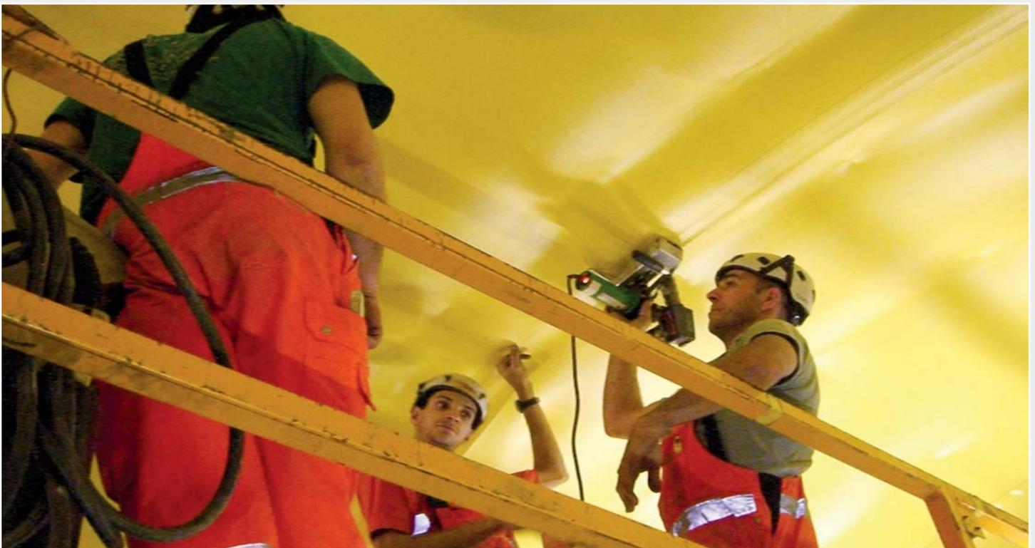
*Überkopf-Schweissarbeiten mit dem TWINNY S.*
