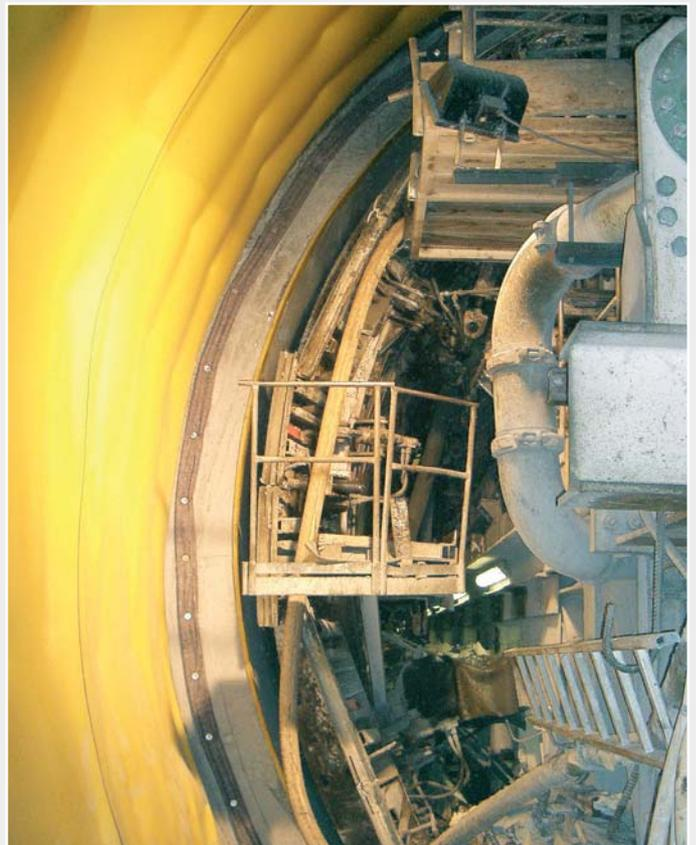
*Die fertig geschweisste Dichtungsschicht vor dem Betonieren der Tunnelinnenschale.*
