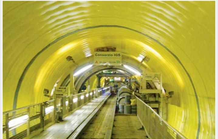
*Fertige Tunnelabdichtung. Die einzelnen Bahnen werden jeweils parallel geschweisst.*
