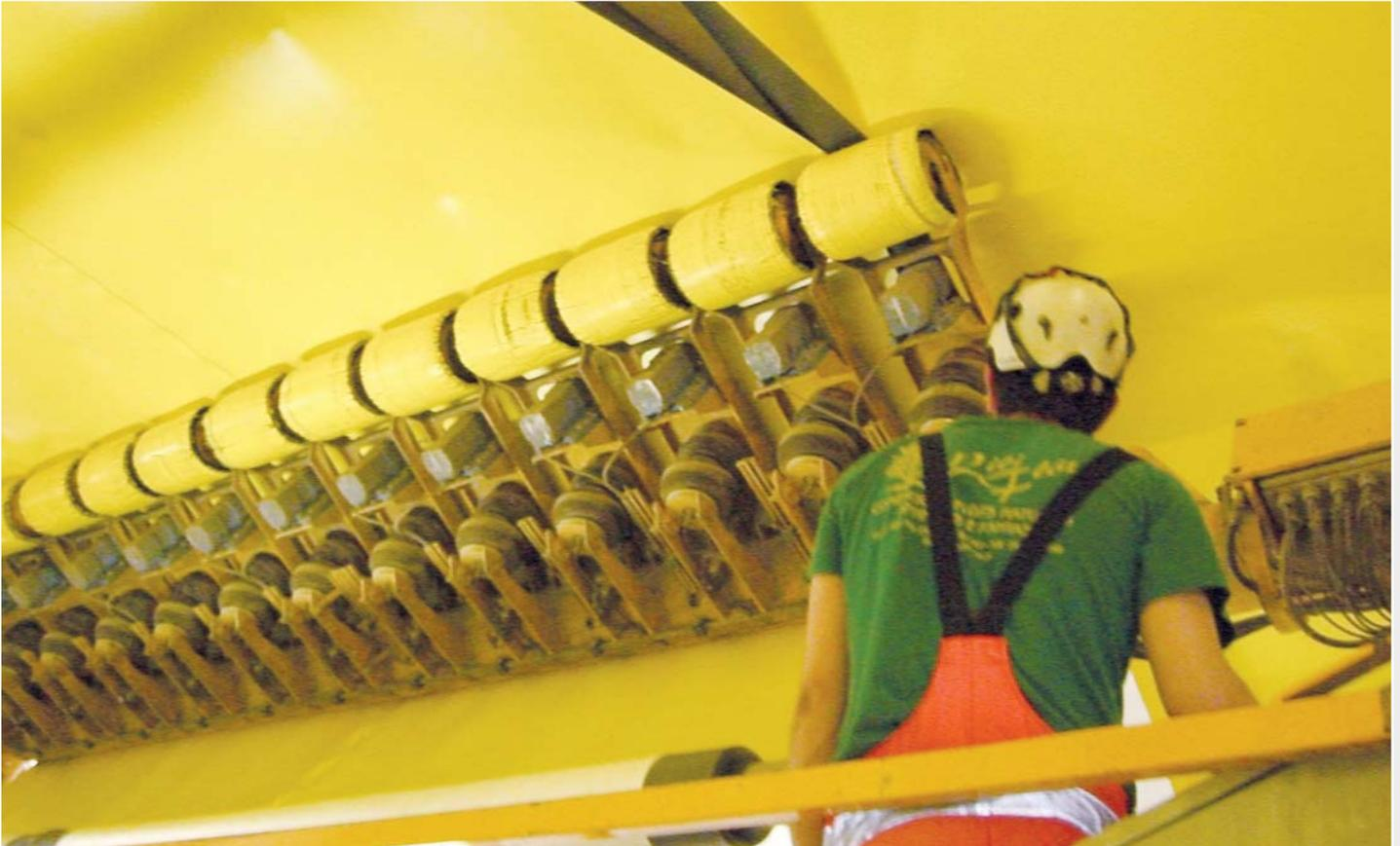
*Das maschinelle Anbringen der vorgefertigten, 4.30 m breiten Kunststoffdichtungsbahnen auf die darunter liegenden Klettertrondellen. Anschliessend wird verschweisst.*
