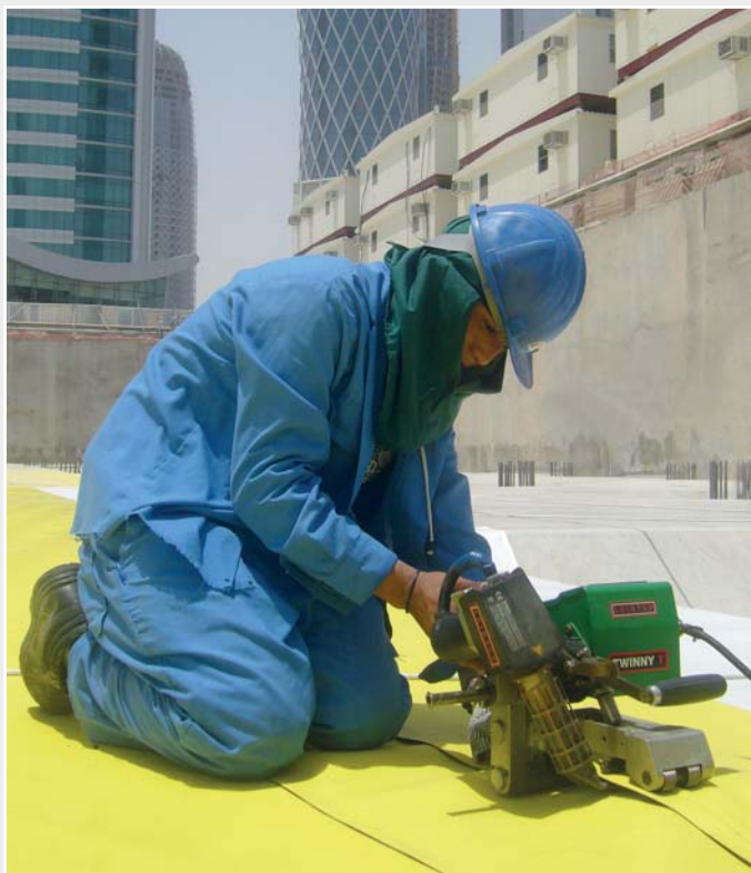
Máquina de soldadura TWINNY T soldando una costura de doble soldadura con canal de prueba.
