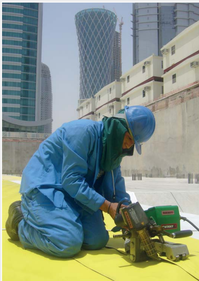
TWINNY T beim Schweissen einer doppelten Schweissnaht mit Prüfkanal.
