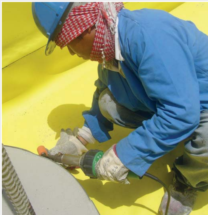
Schweissen von schwer zugänglichen Stellen mit dem Handgerät TRIAC S und Andrückrolle.
