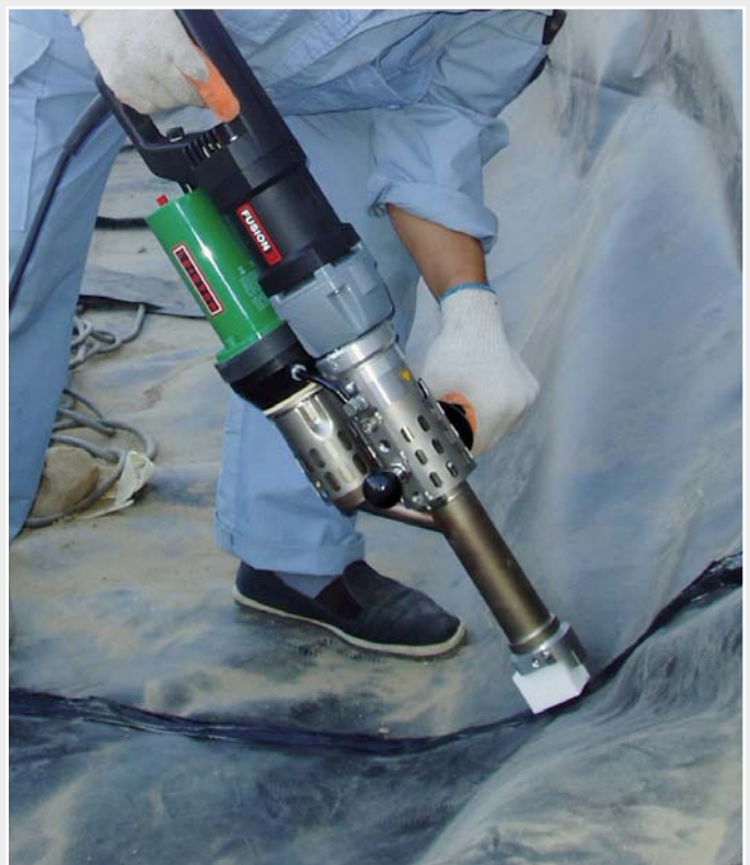
Der Hand-Extruder FUSION 3 für ermüdungsfreies, aufrechtes Extrusionsschweissen.
