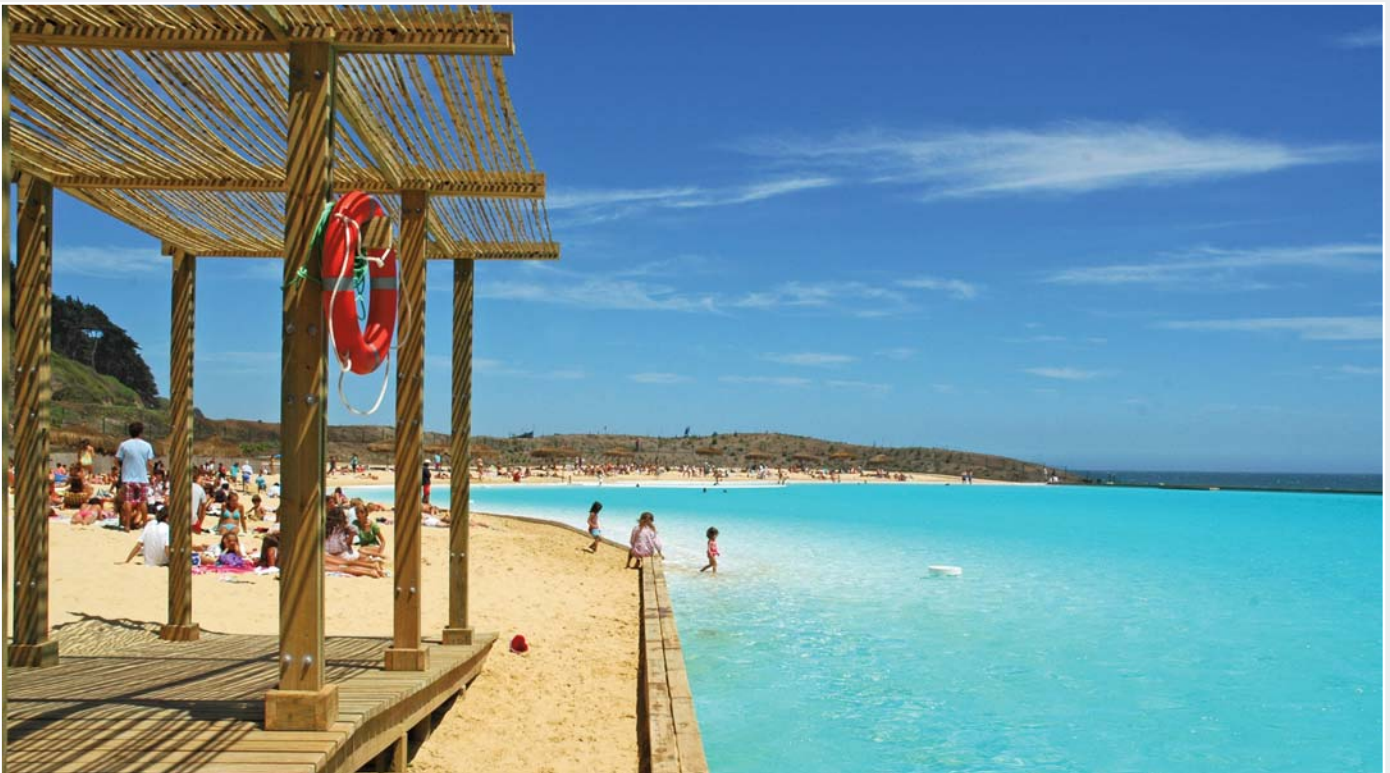
Der fertige Pool in Las Brisas de Santo Domingo, Chile.
