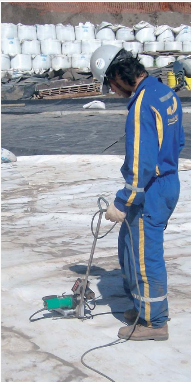
Der kleine und handliche TWINNY S mit Kombikeil beim Verschweissen der obersten Schicht.
