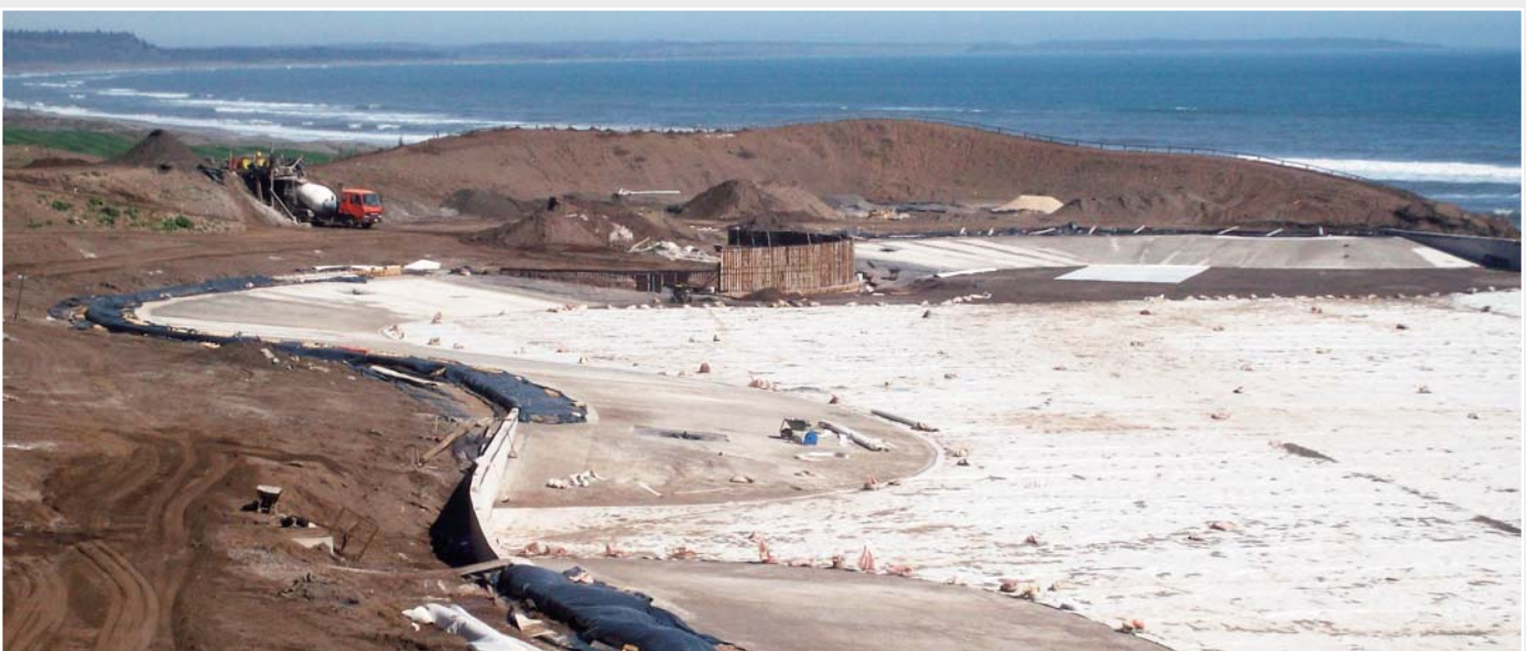
Die Anlage Las Brisas de Santo Domingo im Bau.
