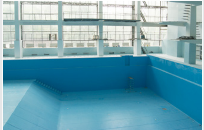
Das fertig sanierte Schwimmbecken.
