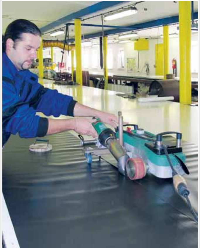
Introducción sencilla de VARIANT T1 durante el proceso de soldadura.
