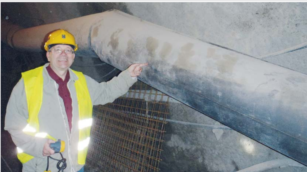
Firmeninhaber Jiri Zajdlik mit einem Duflex-Luftkanal in einem Bergwerksstollen.
