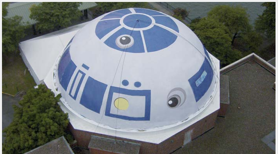
Die fertige R2D2-Kuppel mit einem Umfang von 60 Metern.
