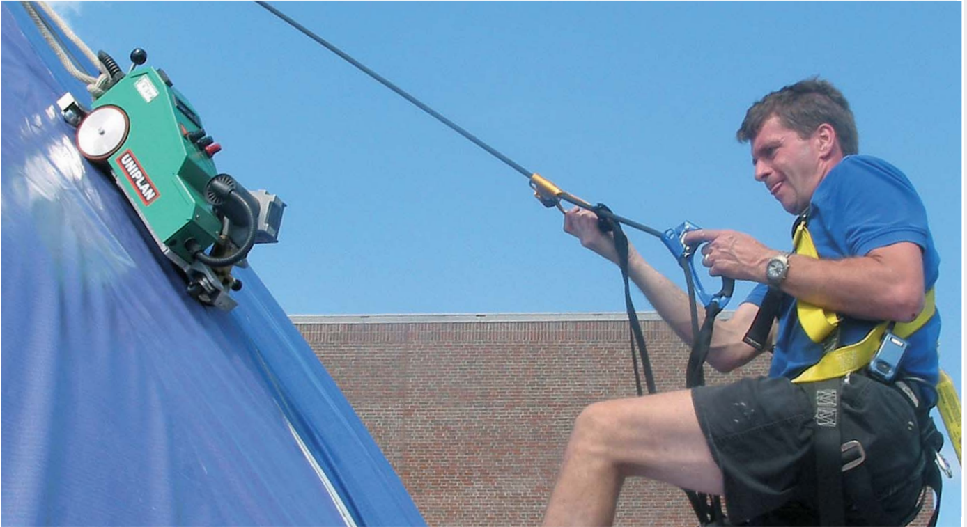
David King kontrolliert das Herunterfahren des UNIPLANB E bei der finalen Schweissung.
