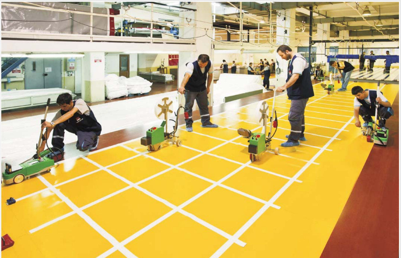
Bei Kadesan sind drei TAPEMAT für die Gurtbänder und drei VARIANT T1 für das Saum- und Überlappschweißen im Einsatz.
