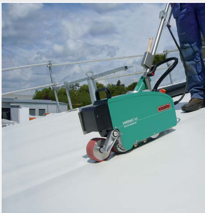
Wykonuje bezproblemowo zgrzewy na dachach o nachyleniu 30°.
