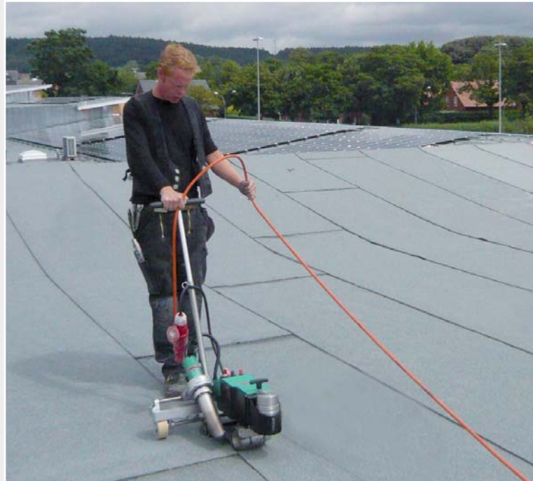
2. Système monocouche Soudage rapide et propre.
